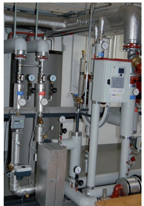
• installierte Wärmeübergabestation
